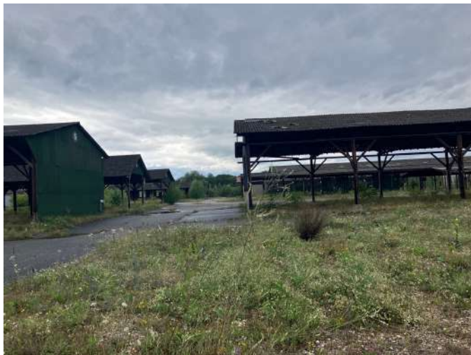
Illustration 9 : Vue vers l'ensemble de bâtiments – 02/08/2023 - Source ARCHIMED Environnement - Fig. 6
