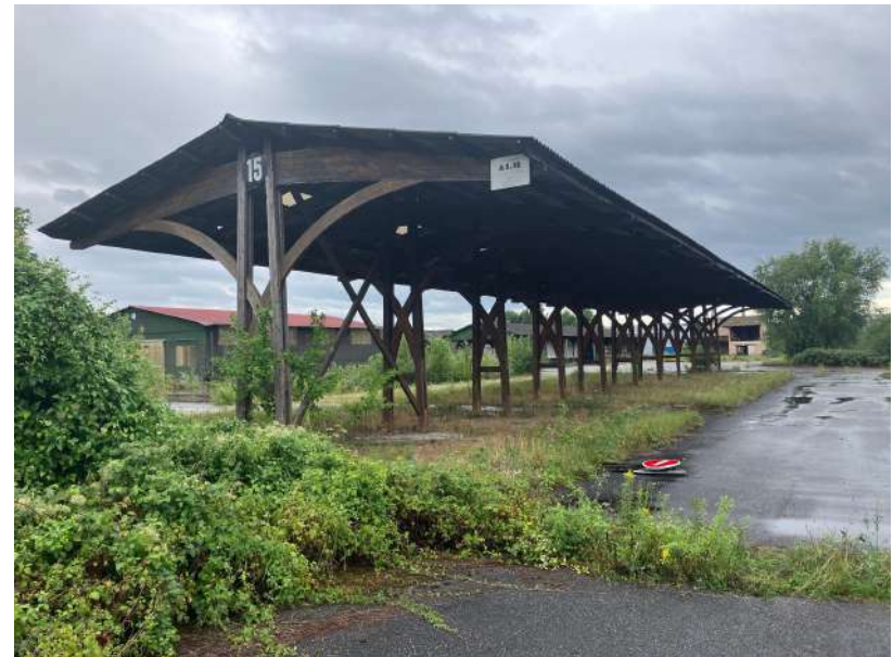
Illustration 30 : Vue d'une partie du site industriel ancien-Source ARCHIMED Environnement
