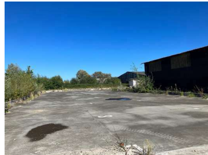
Illustration 11 : Vue vers le Nord– 20/09/2023 - Source ARCHIMED Environnement - Fig. 8
