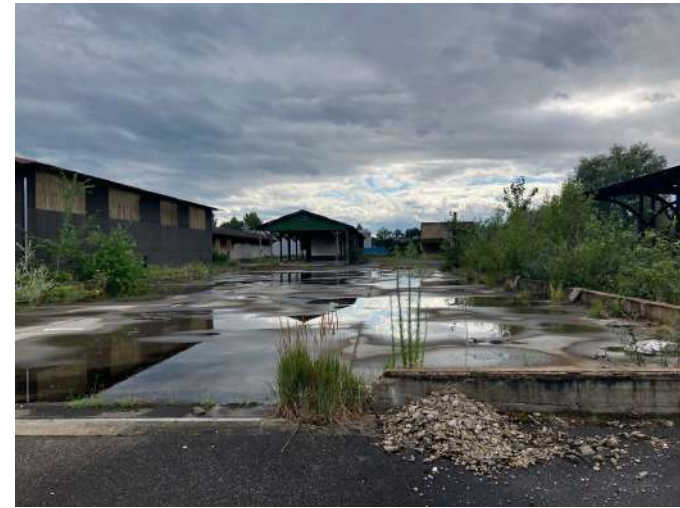
Illustration 10 : Vue vers le bâtiment 11– 02/08/2023 - Source ARCHIMED Environnement - Fig. 7
